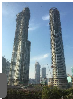
ムンバイで建設中の 高層マンション
